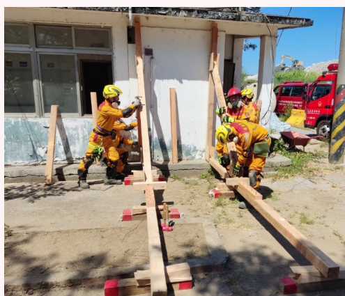
圖 18. 場地布置 (實際操作牆面支撐)
