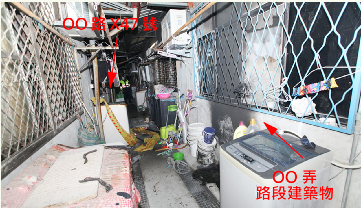
圖 2. ○○路 X47 號西側與周圍建築物部份外牆及地面物品受火燒損
