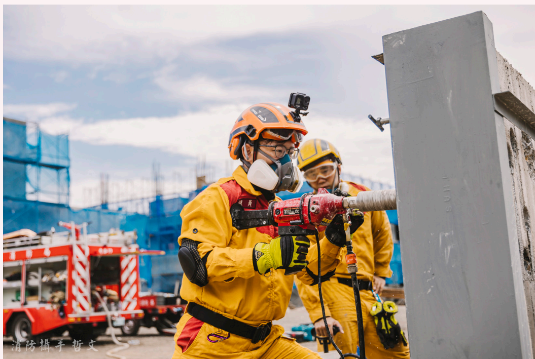
圖 4. 搜救隊成員進行水泥牆洗孔作業
