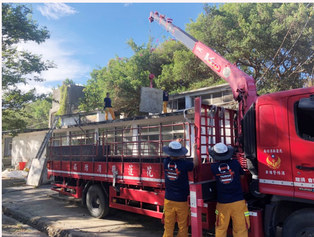
圖 17. 場地布置 (將水泥板放置在屋頂)
