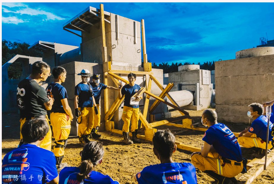
圖 6. 搜救隊成員進行牆面支撐作業
