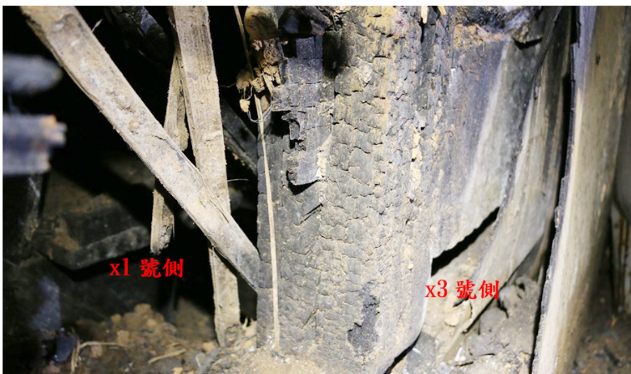
圖六、牆體支架損情形
