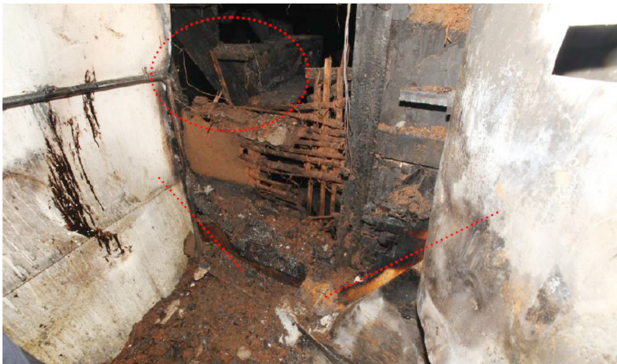
圖五、牆體板材燒損情形
