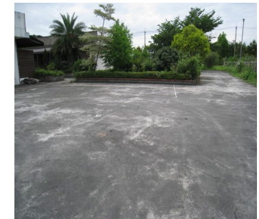
鋪設水泥地面
